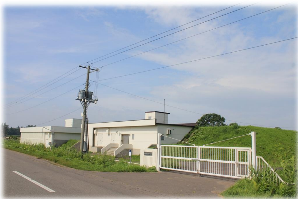
札内配水池（全景）
