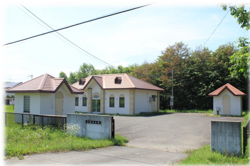
忠類浄水場（全景）
