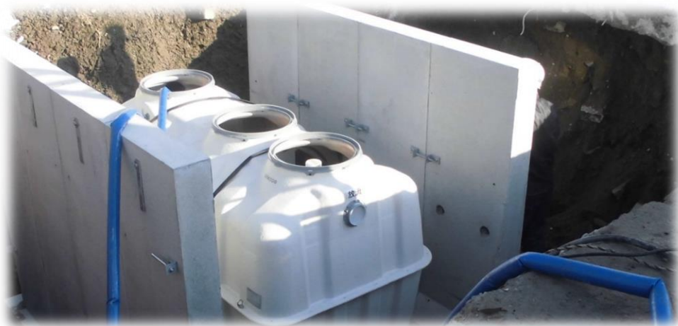
合併処理浄化槽設置工事の様子
