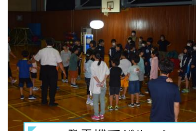
発電機でバルーン ライトの点灯
