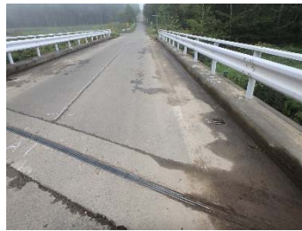
清掃後（橋面土砂堆積）
