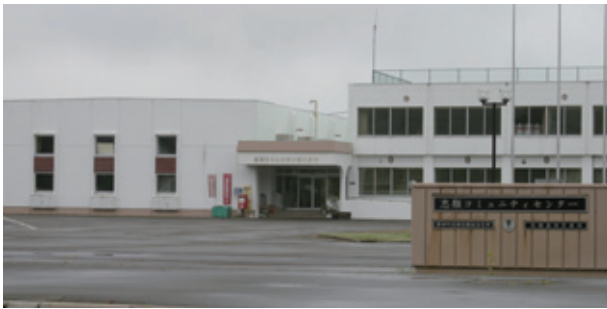
耐震化を実施する忠類コミュニティセンター
