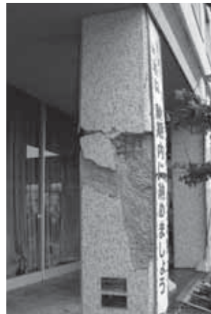
▲庁舎1階の柱がせん断破壊
