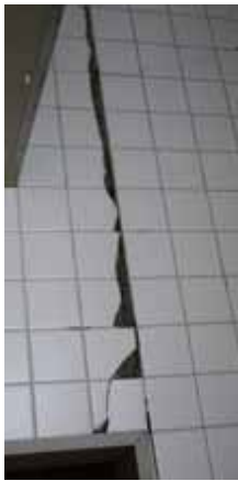
▲庁舎5階のひび割れ
