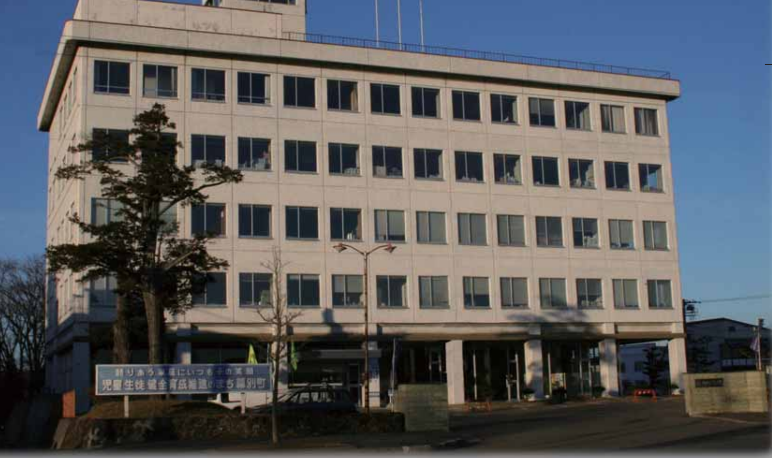
▲昭和47年建設の現役場庁舎
