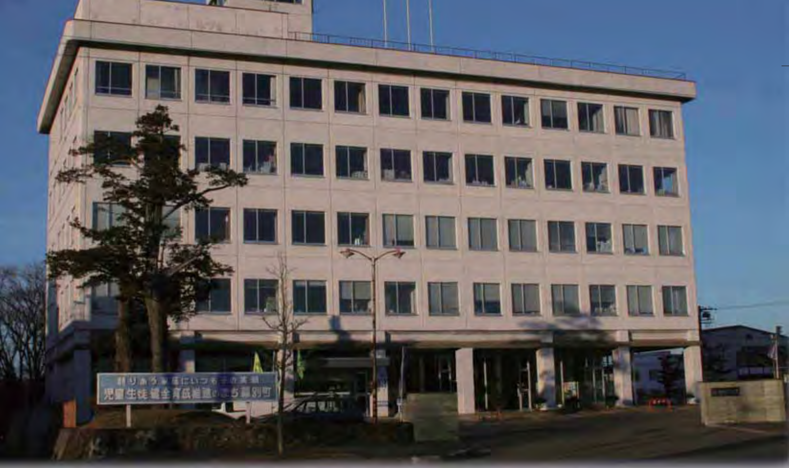
▲昭和47年建設の現役場庁舎
