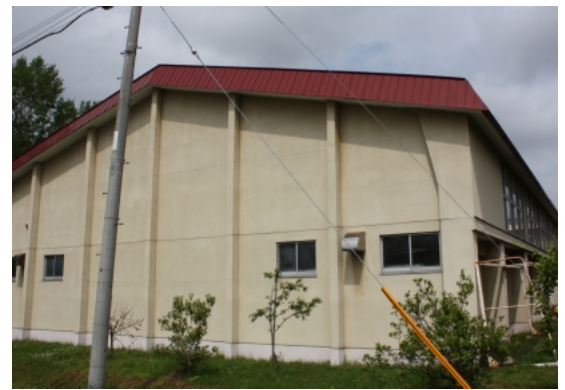
札内南小学校体育館
