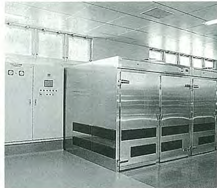
▲食器消毒保管庫・食缶消毒保管庫
