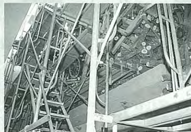
▲足場を組んでの作業
