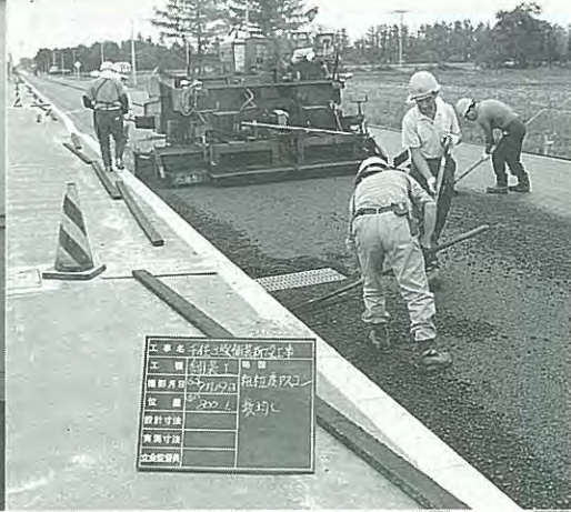
千住3線の舗装工事
