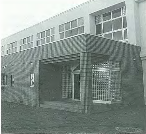
幕別中学校体育館を改築
