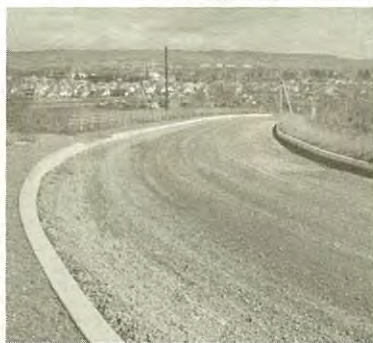
ほぼ工事が完了した札内高台線
