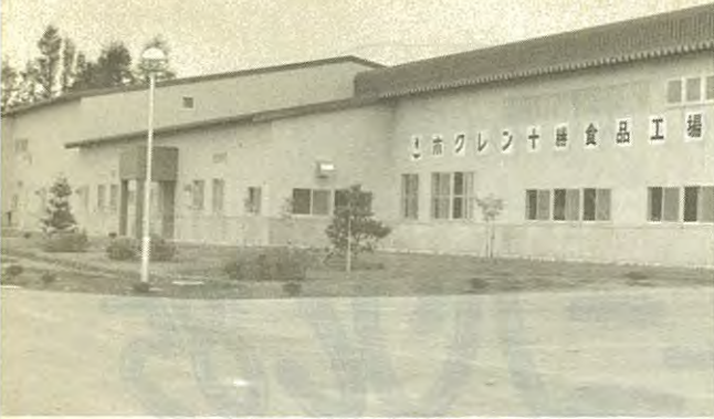
完成したホクレン十勝食品工場
