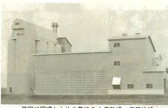
依田に完成した札内農協の小麦乾燥・保管施設
