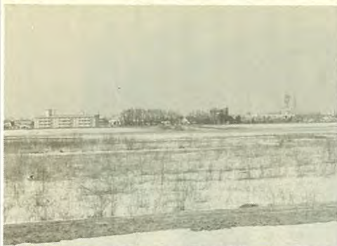
第二札内橋の架橋予定地から帯広を望む(依田)
