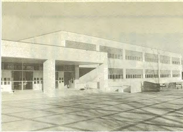
完成した札内東中校舎
