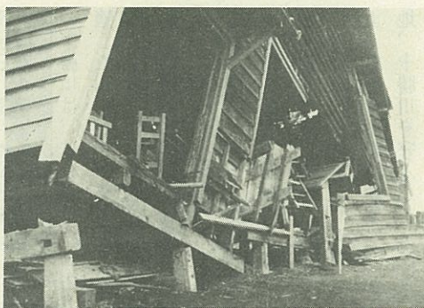
十勝沖地震で崩壊した校舎 (昭和27年3月)
