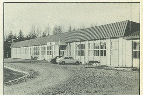
増改築された糠内小学校
