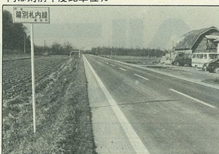
改良舗装された幕別札内線
