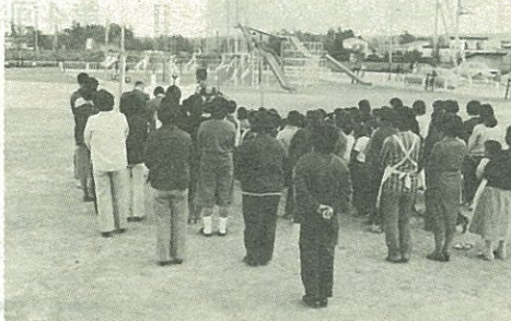
▲ 春より造成が行なわれていた青葉町公園がこの度、完成。青葉町公区では、使用開始に当り公区みんなで安全祈願を行ないました。
