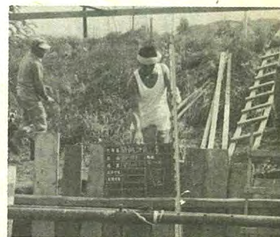
昨年行った上水道本管の延長工事
