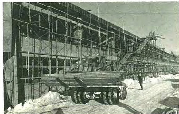
▲昭和53年開校をめざし工事が進む幕別小統合校舎
