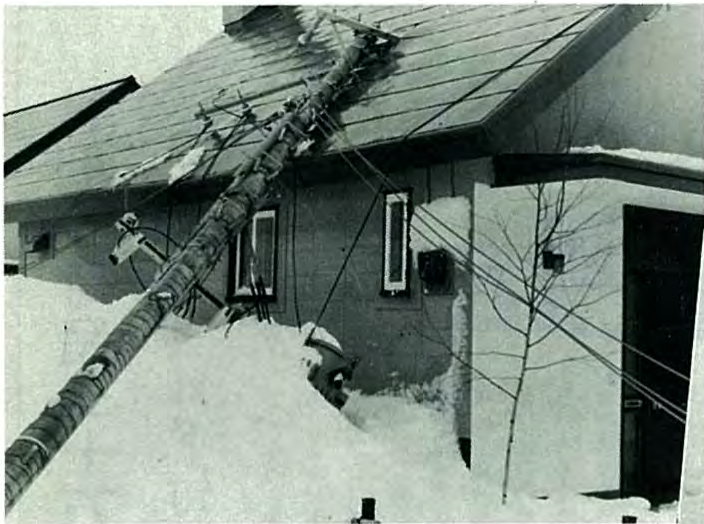
雪の重みに耐えかねて新築の家に倒れた電柱。電柱の腕木が屋根に突きささり「いつ災難にあうかわからない」とは近付の人々の弁（旭町団地にて）
