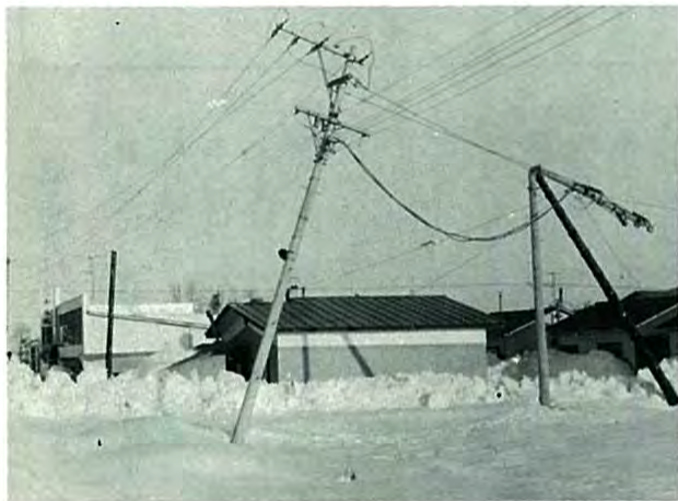
雪の重みに耐えかねて新築の家に倒れた電柱。電柱の腕木が屋根に突きささり「いつ災難にあうかわからない」とは近付の人々の弁（旭町団地にて）
