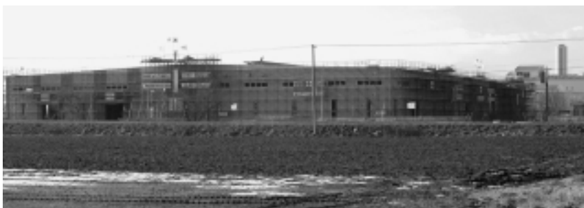
十勝環境リサイクルプラザ（建設中） 「容器包装リサイクル法」に基づき、分別収集した資源を再商品化できる施設。現在、十勝環境複合事務組合（1市3町2村で構成）がくりんセンター（写真右奥）の東側に建設を進めています
