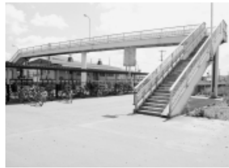
再整備が予定される札内駅人道橋
