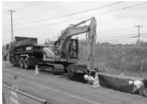
計画的に行っている道路整備
