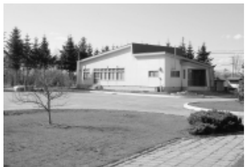
改築予定の稲志別近隣センター
