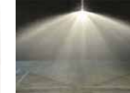
スプリンクラー設備
