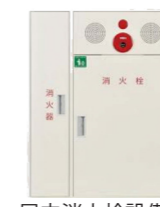
屋内消火栓設備
