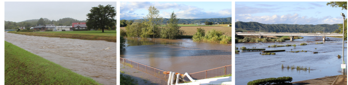
▲忠類市街地北側を流れる当縁川 ▲旧途別川(猿別川樋門付近) ▲パークゴルフ場サーモンコース
