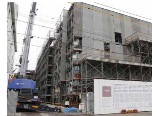
新庁舎建設の様子
