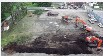
▲工事現場の様子(9月10日撮影)
