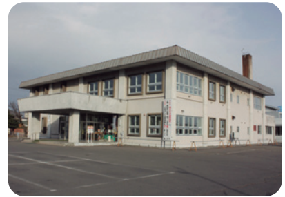
▲平成26年4月で築後40年が経過した札内福祉センター
