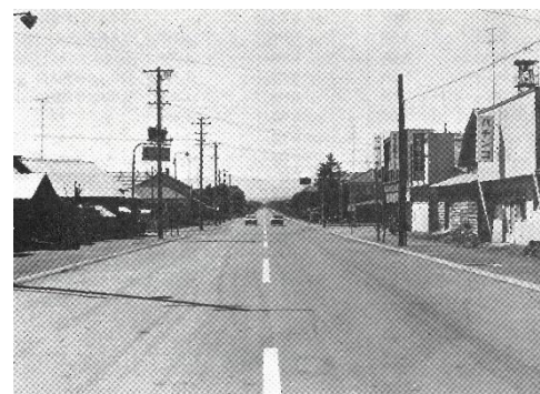
「舗装された国道236号線 忠類郵便局前交差点付近 昭和44（1969）年」
