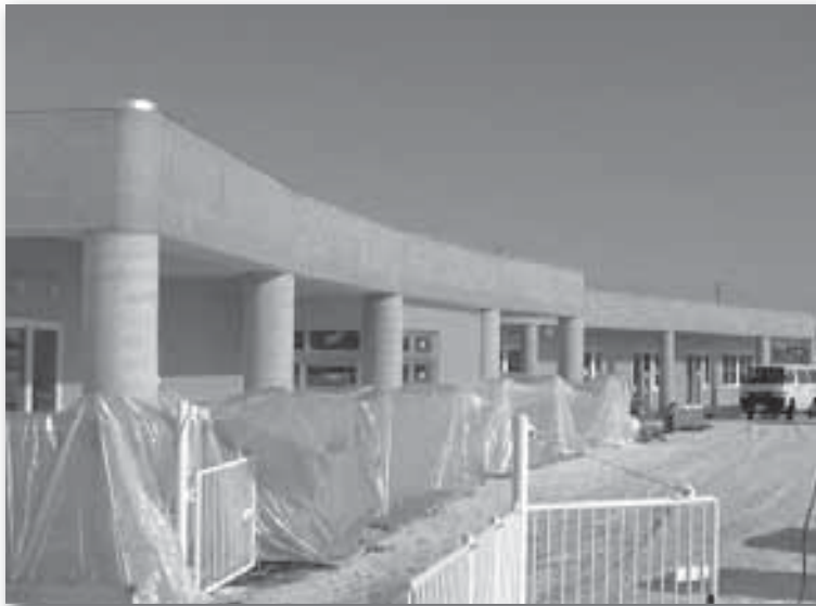
(建設中の札内さかえ保育所)
