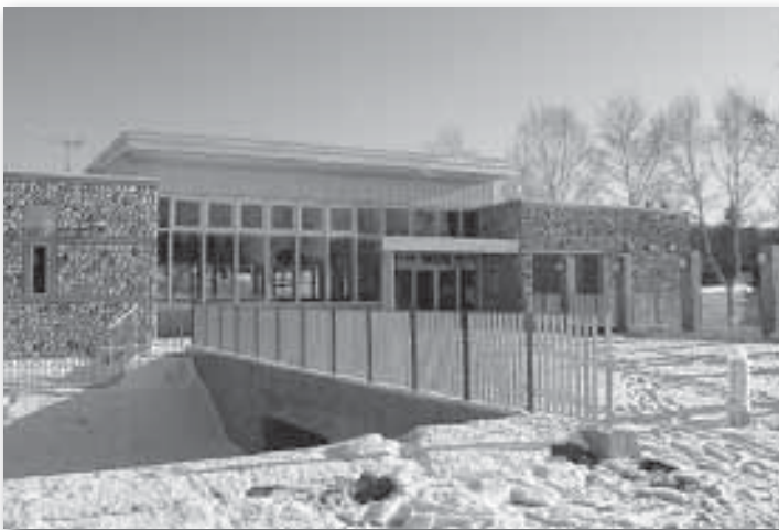
(建設中の道の駅)
