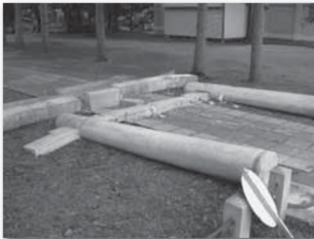
(平成15年の釧路沖地震では幕別神社の鳥居も倒壊する被害がでた)
