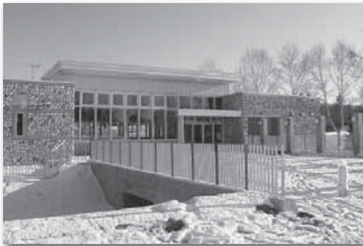
(建設中の道の駅)
