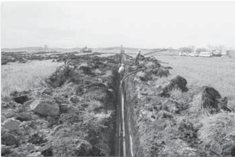
暗きよ排水工事の様子
