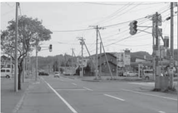
仮設信号機の設置されている交差点
