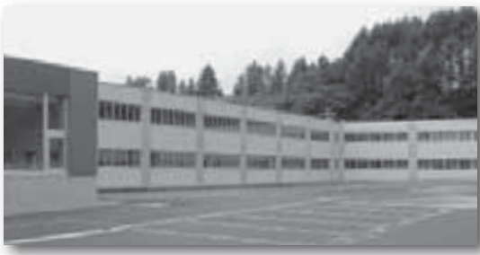
道営住宅とかち野団地(シルバーハウジング)
