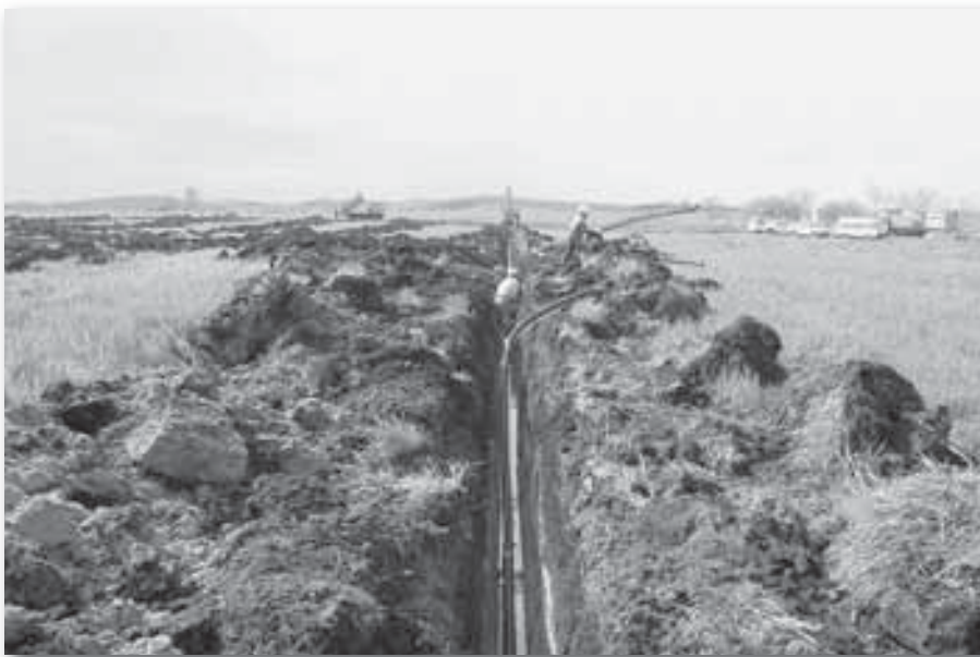
暗きよ排水工事の様子
