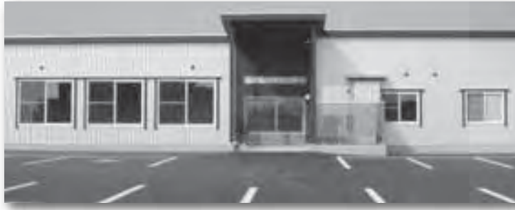
北栄町近隣センター
