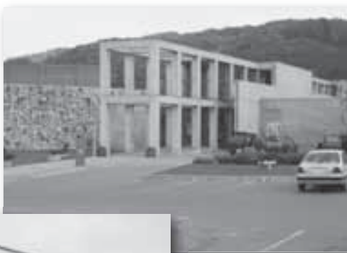
指定管理者制度で運営される両施設
