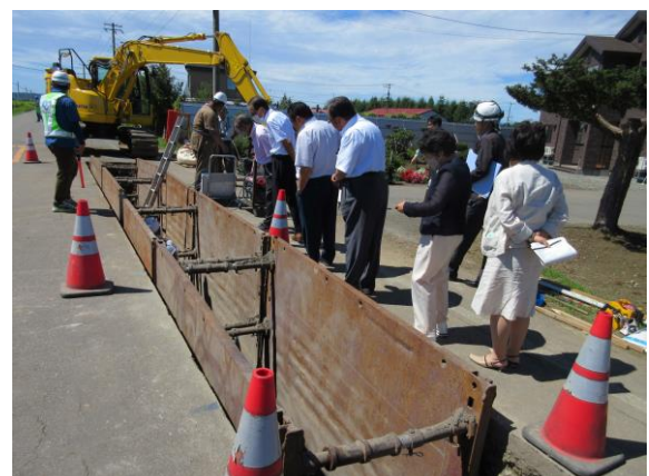
工事現場（明野）
