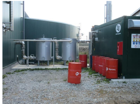
ガスエンジンと脱硫装置
