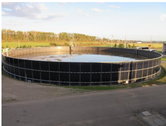
消化液貯留槽
