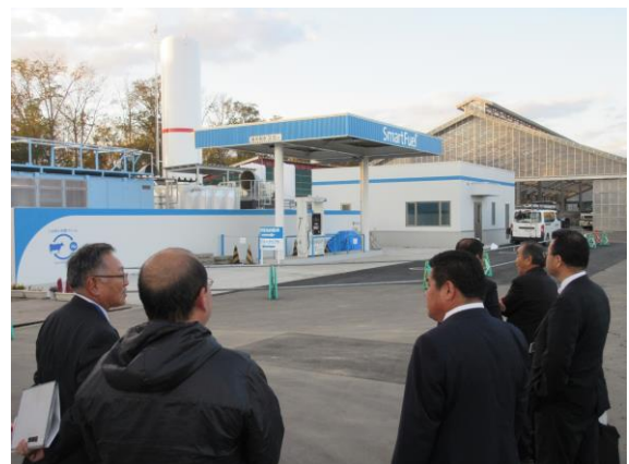
水素ステーション
