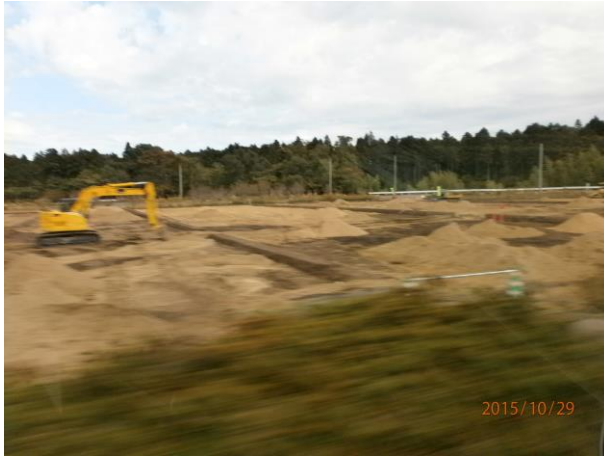
農地除染作業
