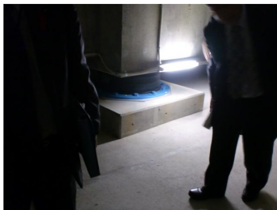
免震ピット内の免震ゴム
